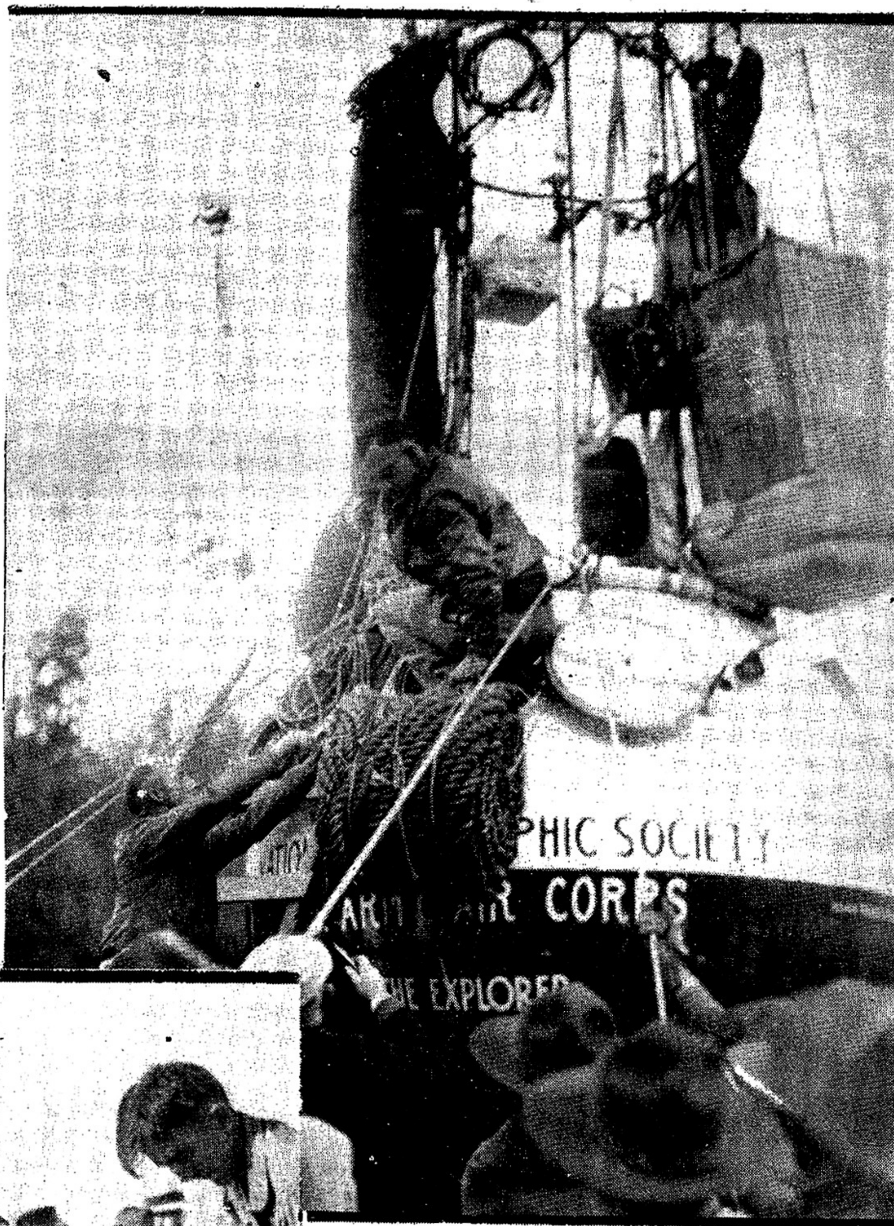
La góndola del "Explorer", en los momentos en que STEVENS y KEPNER introducían en ella los últimos instrumentos para el vuelo y se aprestaban a tomar sus puestos dentro de la esfera metálica.
